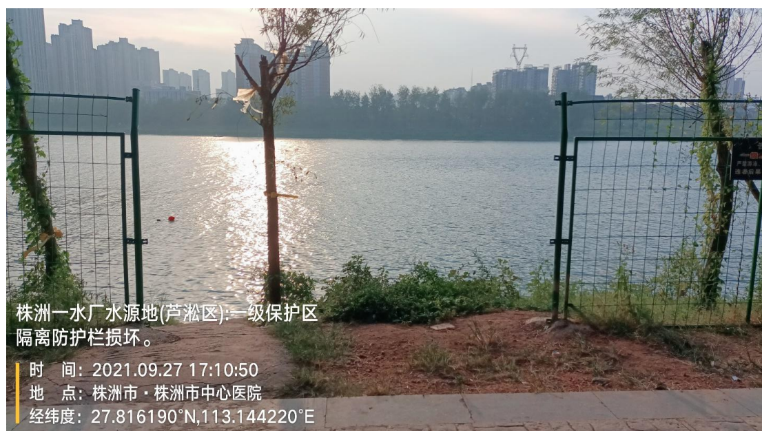
图 6 株洲一水厂、四水厂饮用水水源保护区护栏缺失
